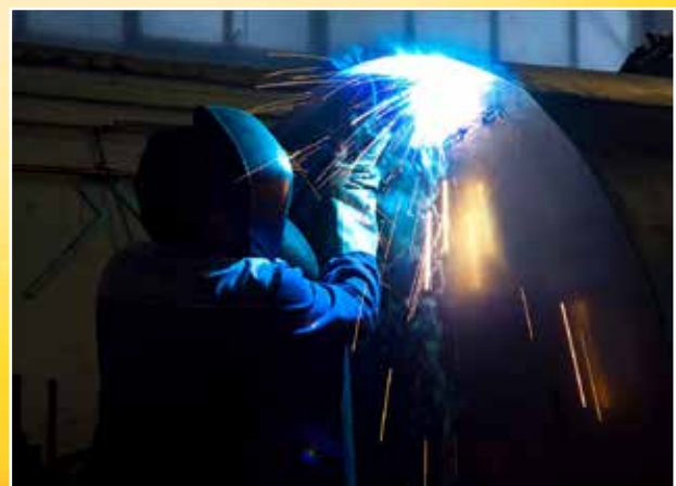
Montage des Schichttrennblechs
