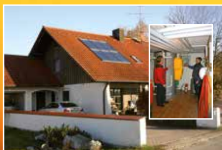
Solaranlage für privaten Bereich
