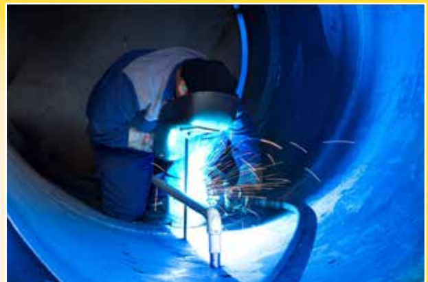
Verlegung und Verschweißung der Innenverrohrung
